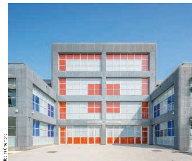
Des caillebotis protègent l'ITE sur les façades en béton.
