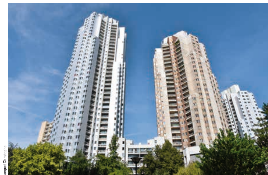
A gauche, une tour réhabilitée, à droite, une autre avec son revêtement d'origine.
