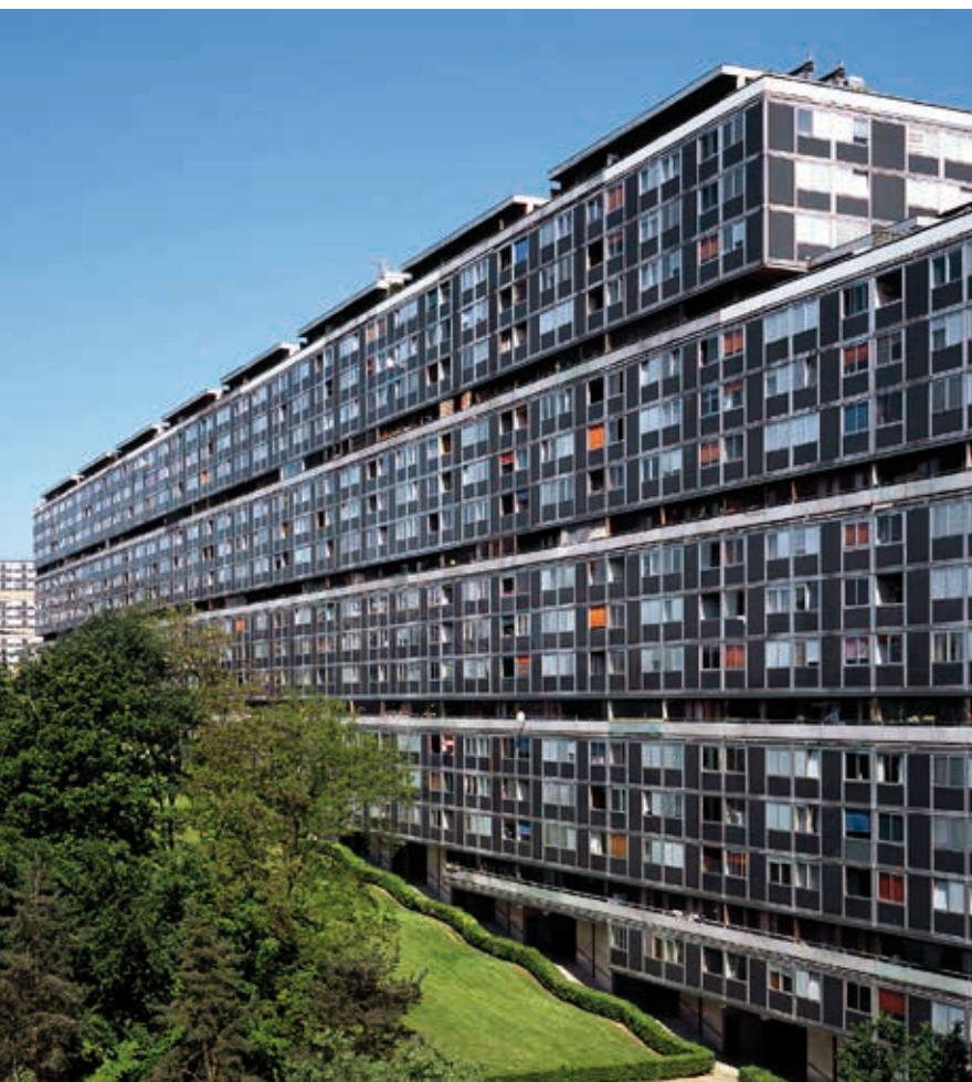
La cité du Lignon a été isolée par l'intérieur (ici en 2011).
