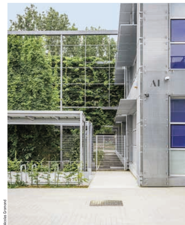
Les caillebotis servent également de brise-soleil horizontaux.
